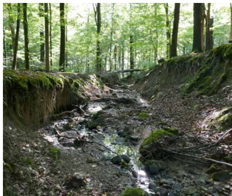
Oberlauf Netzbach mit Erosionsschäden durch Sturzfluten; Foto: W. Lappel
